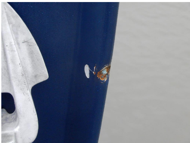
Zijkant door de deuk naar buiten gedrukt
