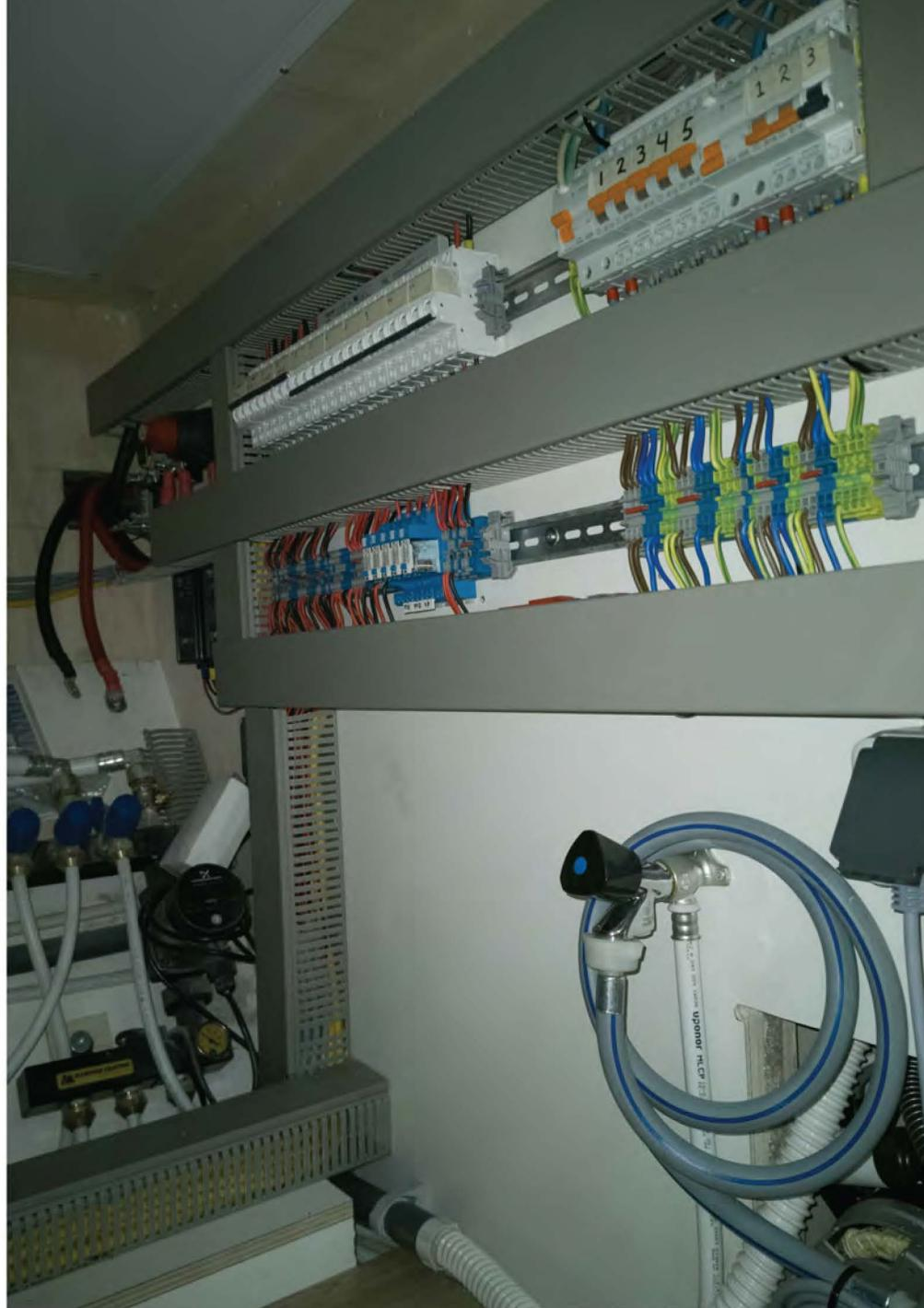
Unter der Treppe. Schaltkasten. Ist noch in Bearbeitung - Stromkabel nicht angeschlossen etc.
