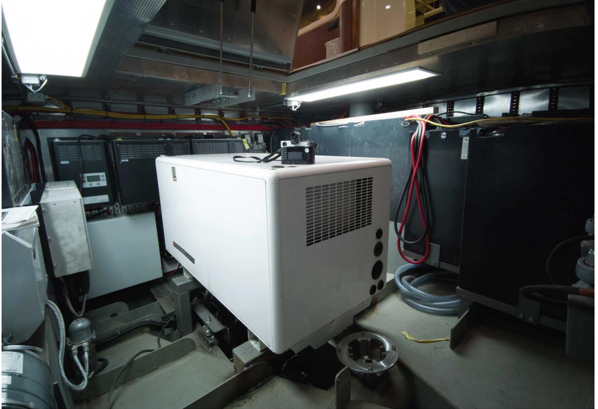
Der zu kleine 25 KW Generator nur aufgesetzt und nicht angeschlossen.
