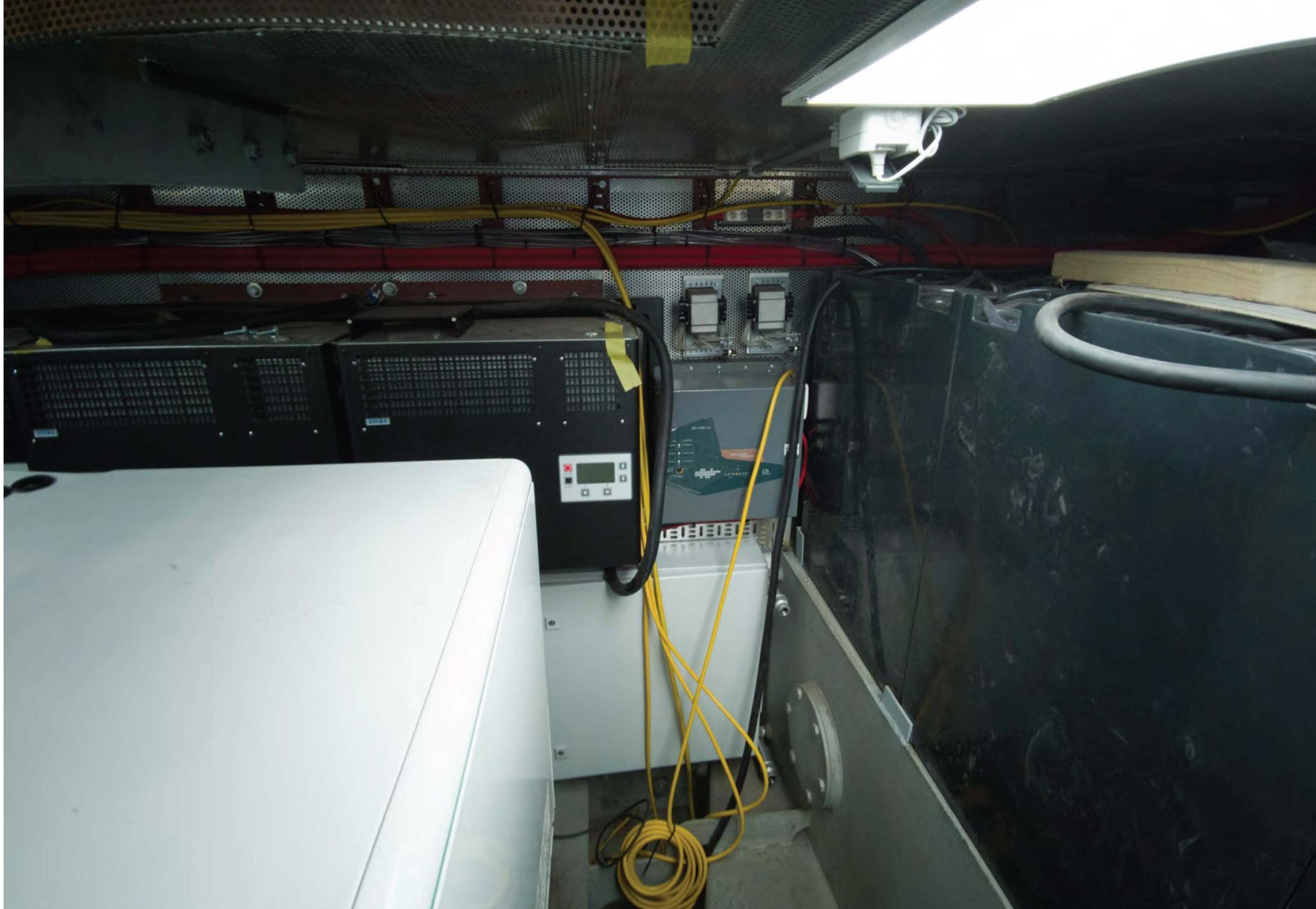
Es hat nur einen 3.5 KW Inverter. Wir hatten verlangt, Platz für einen zweiten Inverter zu lassen. Es wird später ein zweiter Inverter benötigt werden. Wir brauchen den vorgesehenen Platz dafür. Die zwei Pumpen für das Füllsystem der Batterien wurden noch nicht angeschlossen und das Kühlsystem auch nicht.
